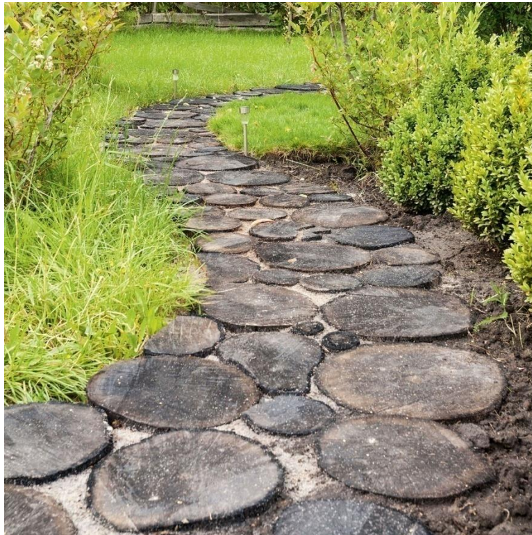
Примерная конструкция торцового покрытия
